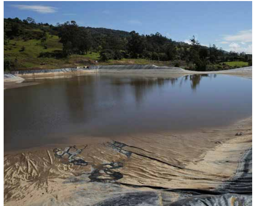
Talsperre von Vélez (Quelle: Gobernación de Santander)
